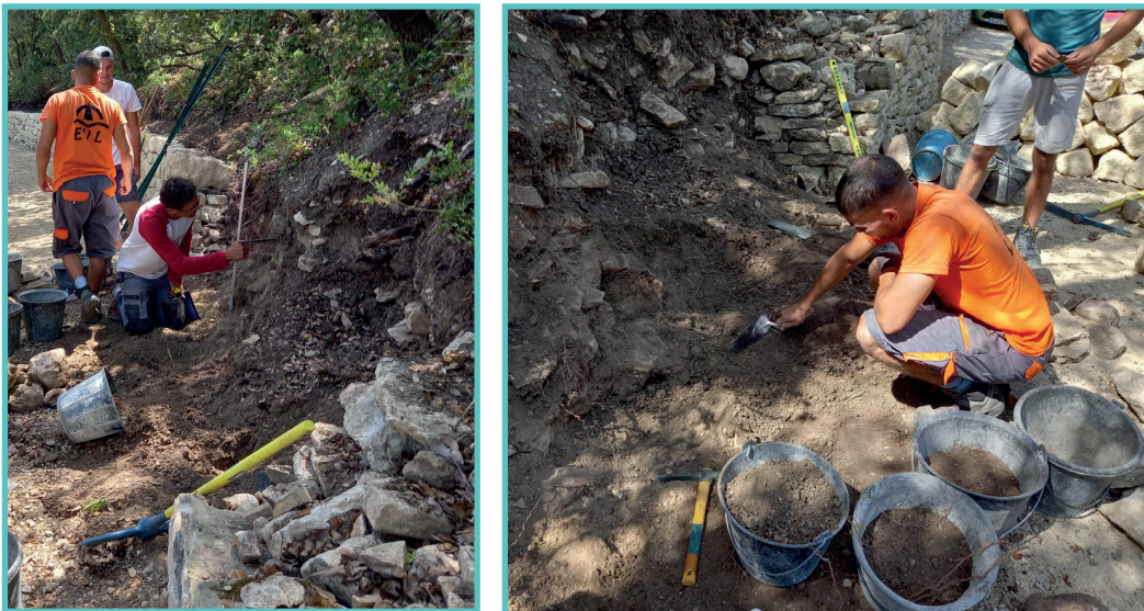
Photos de la réalisation du fond de forme
